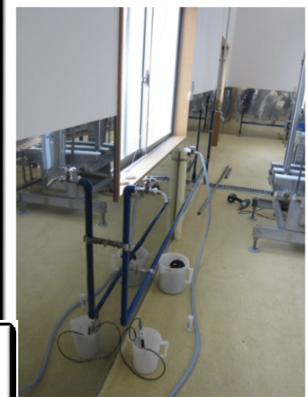
場内衛生用電解水専用蛇口
